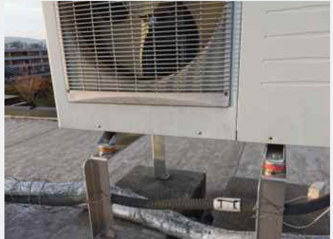
Isolation de pompe à chaleur avec Isotop Compact
