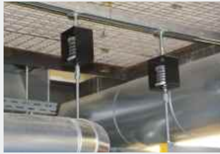
Tuyauteries découplées avec Isotop SD/Z
