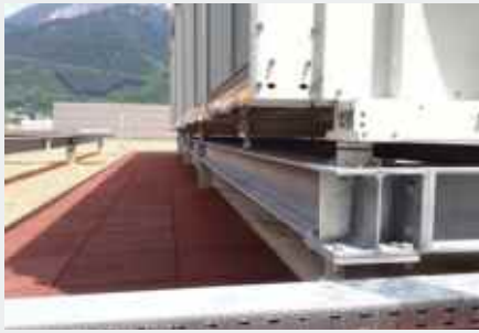
Refroidisseur avec Isotop DZE soumis à des vitesses de vent élevées
