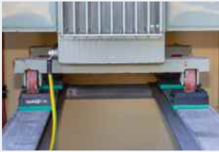
Isolation des vibrations générées par un transformateur
