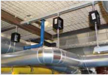
Suspentes de tuyauteries et canalisations avec Isotop SD/Z
