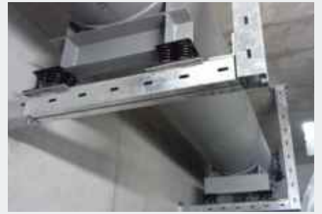
Isolation de conduits d'échappement
