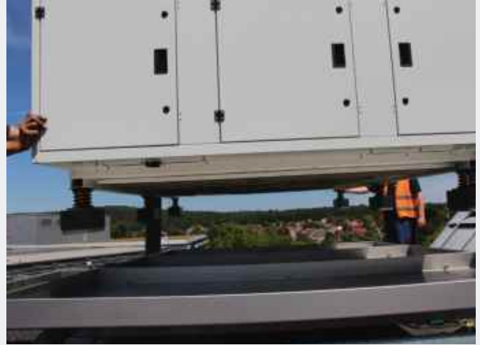
Installation de l'appareil avec Isotop DT prémonté
