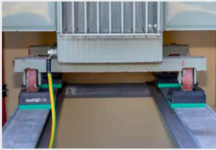
Isolation des vibrations générées par un transformateur
