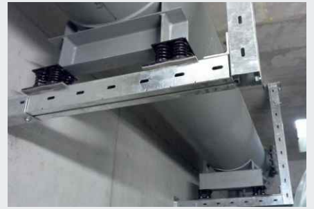
Isolation de conduits d'échappement
