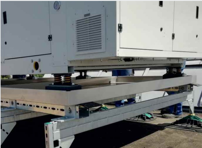
Installation de l'appareil dans le bac de rétention
