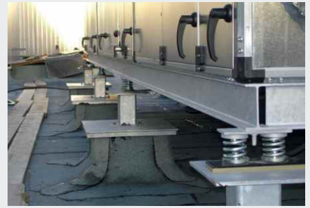
Installation VMC en toiture
