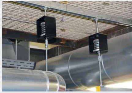
Tuyauteries décollées avec Isotop SD/Z
