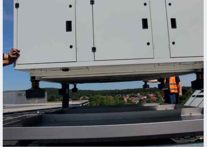
Installation de l'appareil avec Isotop DT prémonté
