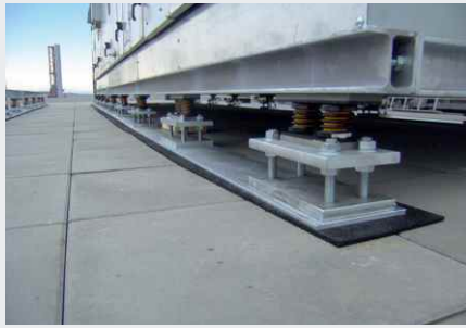
Installation d'une VMC sur un toit avec efforts liés au vent élevés
