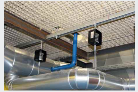
Suspentes de plafond Isotop MSN/Z-LC
