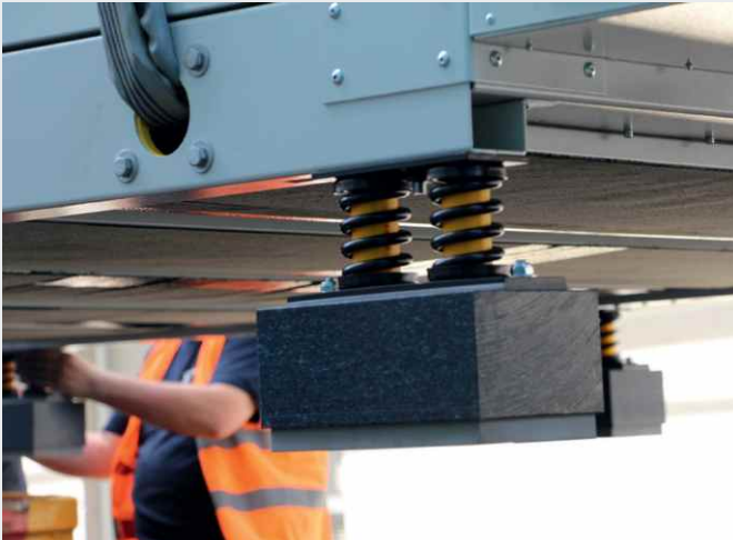
Isotop DT prémonté sur le bâti
